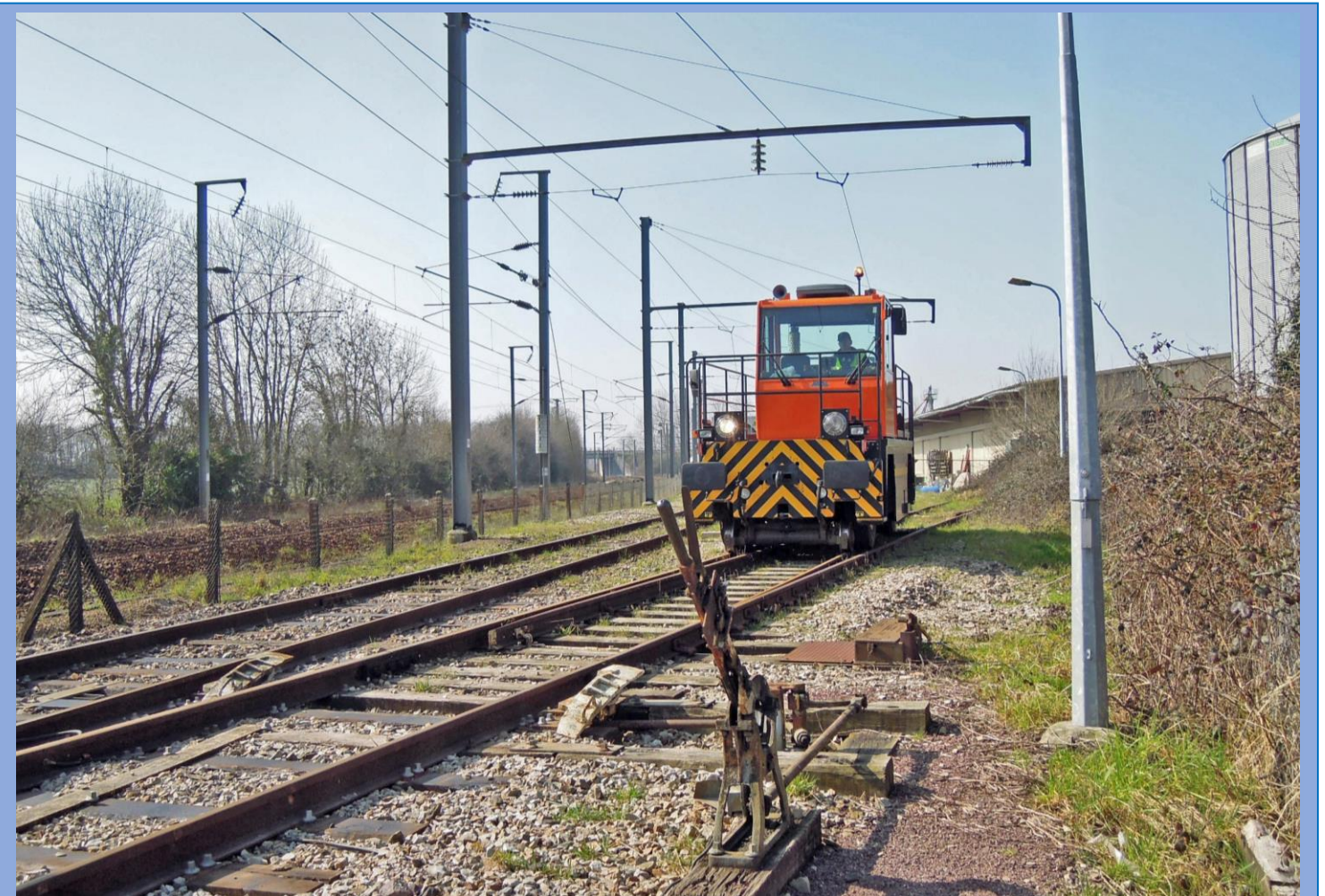
A Valognes, le rail-route de construction MOL manœuvre sur l'embranchement propriété de la ville. Il refoulera bientôt vers la plate-forme les wagons de matières radioactives – Photographie Marc Le Rochais
