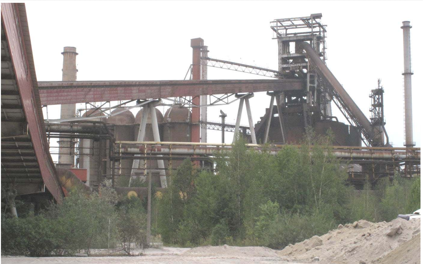
Le HF n°3 de HK : à droite les 4 cowpers ; au centre le convoyeur pour le chargement du HF -photographie Patrick Etiévant -
