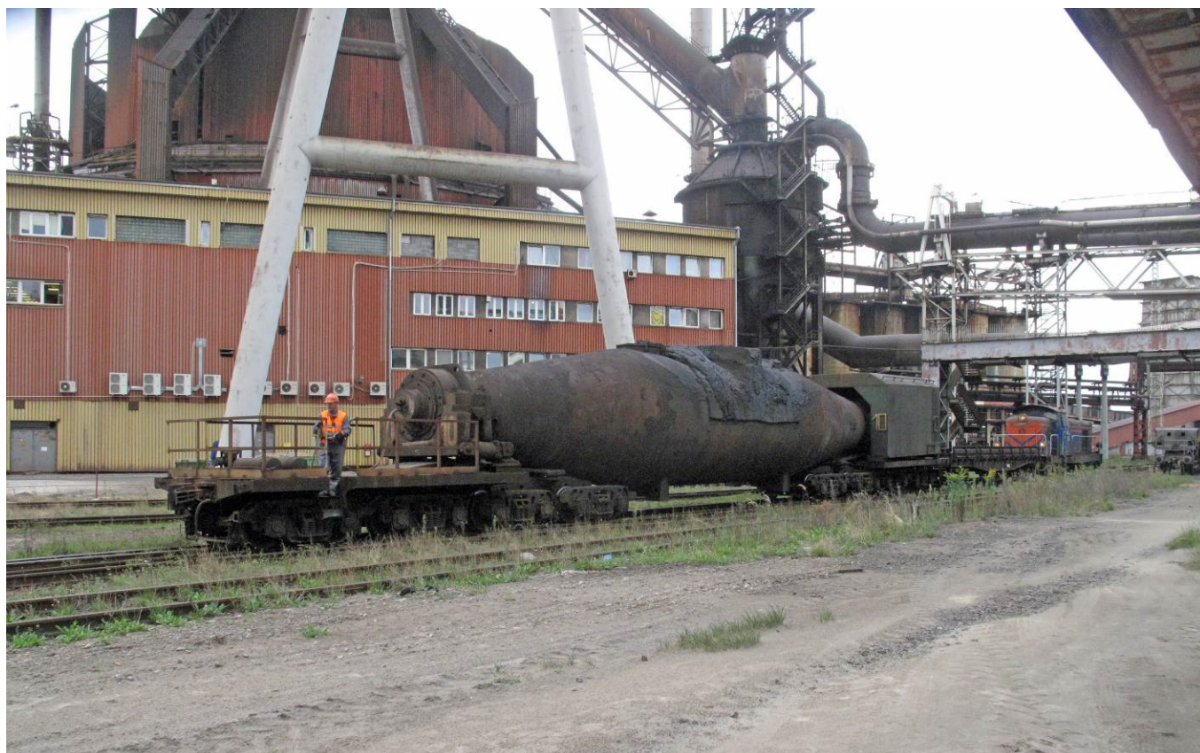
Le wagon à poche torpille n°10 est refoulée par la SM-42 n°68. Il passe juste au pied des jambes de soutènement du convoyeur de chargement du HF n°3. On observe une partie des installations de dépoussiérage du HF 3 à droite. -photographie Patrick Etiévant -
