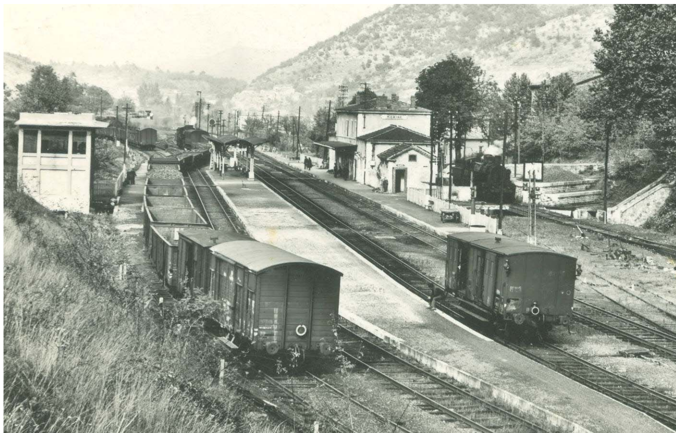
Pointe de trafic ferroviaire en gare de Robiac vers 1950. Pas moins de trois 050A sont présentes en gare : la première à droite stationne devant le pont tournant de 14 m de l'annexe traction ; la seconde au centre, tender en avant tracte un train de tombereaux vides en direction de Bessèges ; tandis que la troisième à gauche stationne avec quelques tombereaux sur la voie en direction de La Valette – collection privée -
