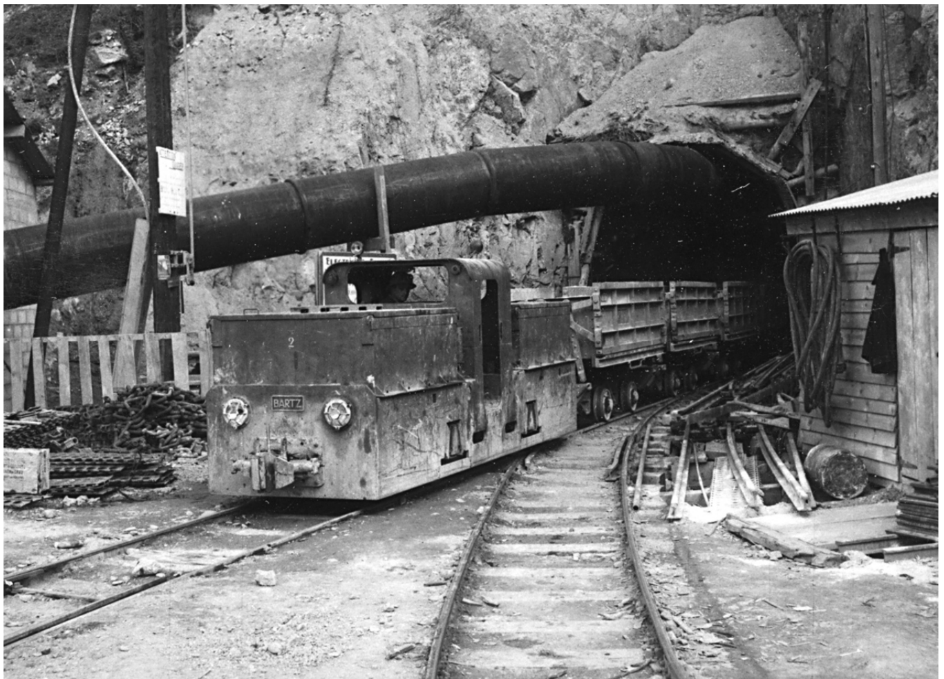
Le locotracteur électrique à accumulateurs Bartz à voie métrique sort de la galerie d'amenée avec des berlines Austin Western. Le numéro 2 permet d'identifier la 2 ème caisse d'accus du locotracteur – photographie Fenwick
