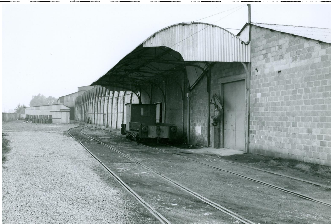
Usine Renson : l'embranchement et le locotracteur électrique captant le courant par perche et fil trolley . note de Patrick Etiévant : cet engin pourrait être le locotracteur diesel CAMPAGNE type TN livré à Landrecies le 28 avril 1932 sous le n°1622, et ultérieurement électrifié à cause des pénuries de carburant dues à la guerre de 1939-1945
